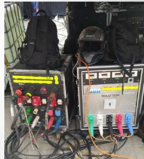
**Plantas eléctricas de 150 kva y 100 kva, acometida eléctrica, encauchetados y cajas de punto de luz**
